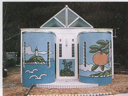
カラフルで中も明るい公衆トイレ
