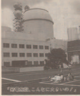
発電所。ここに火のいのちが
