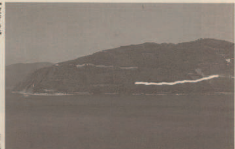
室鼻海水プールに泳ぎに行く道路が、コーストMURO整備事業でアクセス道路として改良されます。工事は今年と来年、2ヵ年で行われ、今年は道路幅4m、延長560mの区間が工事されます。
