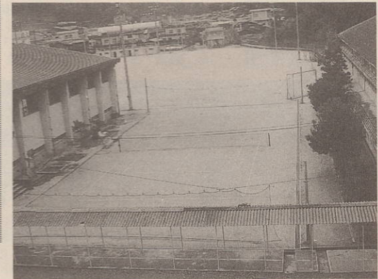
伊方中学校にテニスコート新設(旧校舎取り壊し含む)
