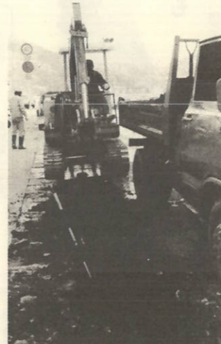
▲⑤町内全域の水道幹線布設工事始まる
