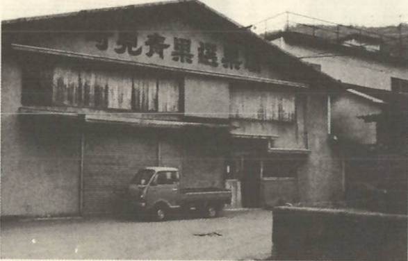
【写真上】町見農協集荷場の完成予想図、鉄筋コンクリート造り2階建てで、12月末完成の予定。 【写真下】旧建物
