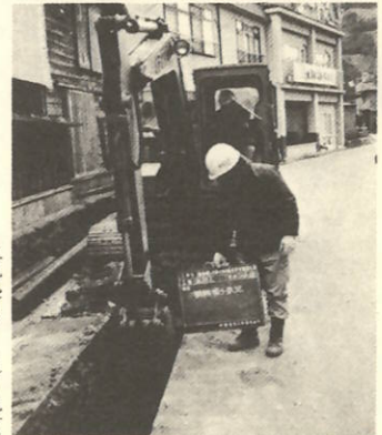
伊方上水道の幹線3kmを布設替え
