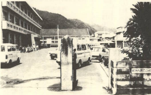
現在の伊方小学校、正面の講堂は今年度体育館として新築。
