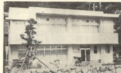
大浜集会所 鉄筋コンクリート2階建 延268.23㎡ 工事費 2,569万円(附帯工事費含む)
