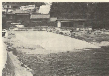
(2) 仁田之浜舟揚場新設 延長10m 幅員27m 事業費 3,040千円(交付金3,000千円)
