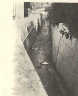
(19) 大成排水路整備 延長 112.6m 幅員 0.7m~1.78m 事業費 3,180千円 (交付金1,500千円)
