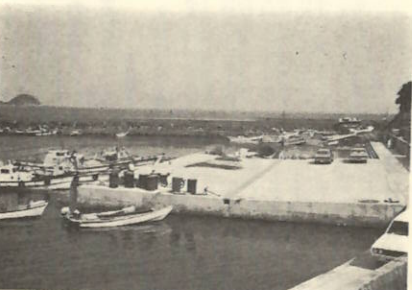
(15) 田之浦漁港物揚場新設 延長 30m 幅員 20m 事業費 25,200千円 (交付金 25,200千円)
