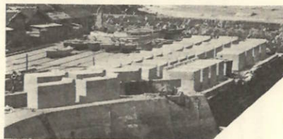
(18) 大成漁港けい船護岸舟揚場新設 延長34mの堤体ブロック33個を製作 事業費 5,600千円 (交付金 5,600千円)
