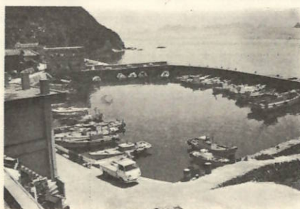
(1) 大浜港浚渫 大浜港内の海底の土砂を1,577㎡とりのぞき水深1mであったものを2mにしました。 事業費 2,500千円(交付金2,500千円)
