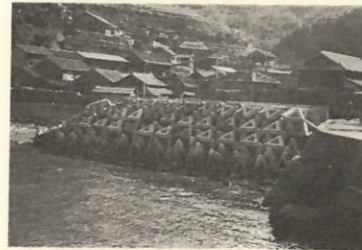
(17) 鳥津漁港護岸(消波工)新設 延長 27m 事業費 8,600千円 (交付金 8,600千円)
