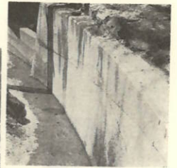
⑩ 伊方越排水路整備 三面張工法で200m整備 事業費 2,450千円 (交付金 1,200千円)
