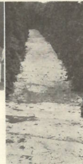
(6) 大浜小屋敷線舗装 墓地参道 104m コンクリート舗装 事業費 540千円 (交付金 500千円)
