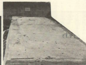
(7) 中之浜東海岸線新設 延長10m 幅員2.5m 事業費 550千円 (交付金 500千円)
