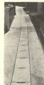
⑰ 加周排水路整備 4面張工法で46m改良 事業費 634千円 (交付金 300千円)
