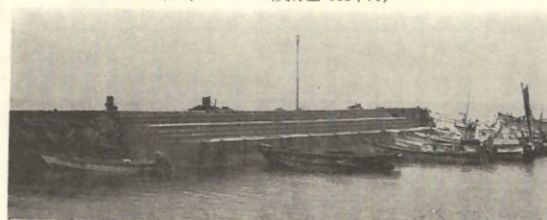
⑱ 田之浦漁港けい船新設 延長30m新設 取付道30.5m補強 事業費 10,400千円 (交付金 10,400千円)
