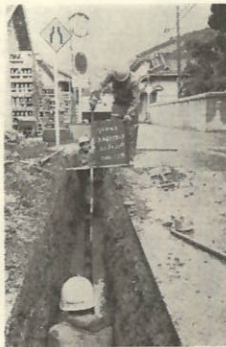
(8) 伊方上水道補強工事 (川永田地区) 配水管10mm 570m布設 事業費 10,500千円 (交付金 10,500千円)
