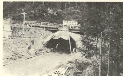
早くも70メートル掘り進んだ大峠トンネル (鼓尾側)
