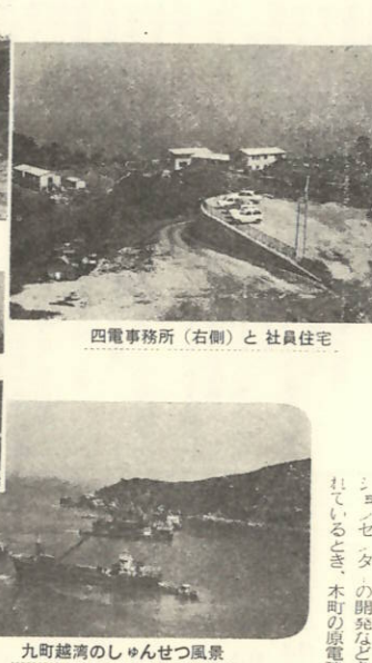
四電事務所(右側)と社員住宅
