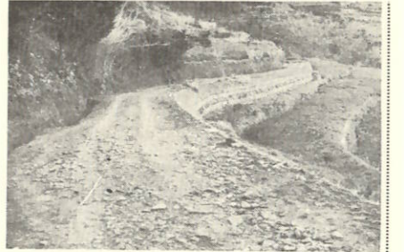
昭和30年度に始めて、昭和32年度に竣工し、完了した、町道鳥津大成線 (一般失対)
