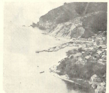
昭和28年度から毎年継続で修築を続けていく豊之浦漁港 (33年度は海岸道路新設)
