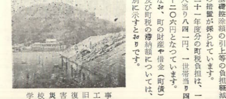
学校災害復旧工事
