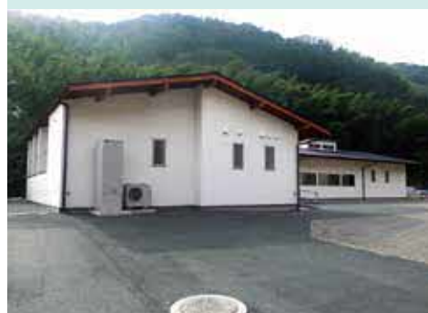
障がい者グループホームの整備
