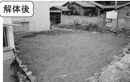
解体撤去により安全性を確保
