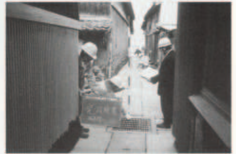
大佐田地区簡易下水道整備工事
