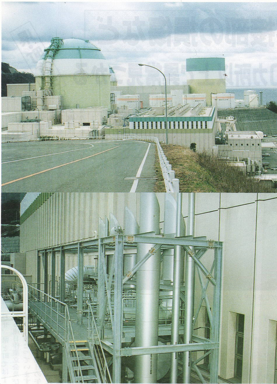
【写真上】ドーム型の建屋が3号機、右側が1号機。 【写真下】故障で蒸気が噴出した逃がし弁と排気管。タービン建屋東側にある。
