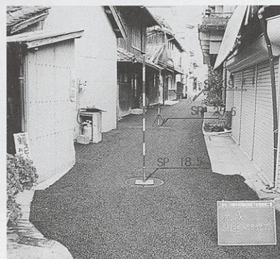
▲三崎(中村)地区簡易下水道整備
