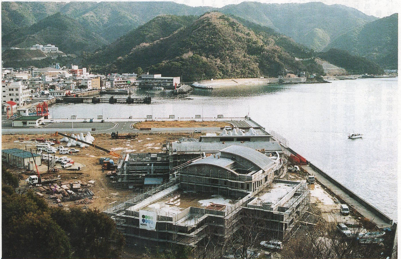
三崎町の表玄関に建設中の「三崎町保健福祉センター」
