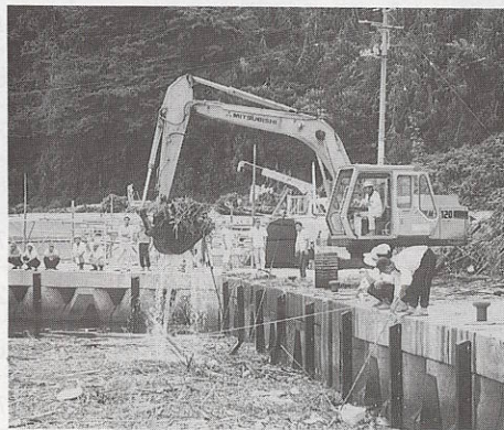
重機による除去作業
