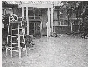
運動場・教室に水が浸入 (三崎中学校)
