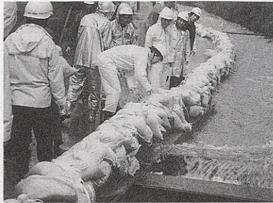
土のう積をする (消防団)
