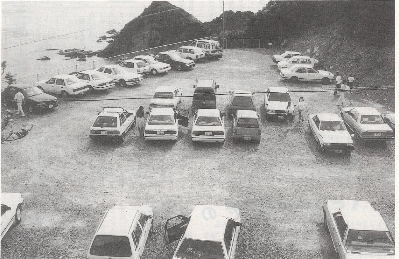
県道終点に完成した駐車場
