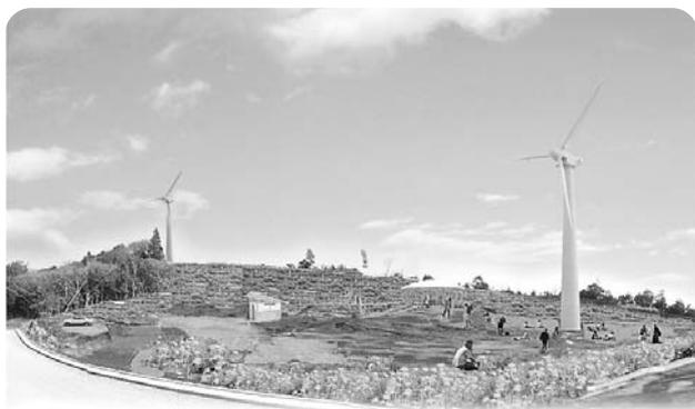
風車の高さは50m、プロペラの直径は61mで出力は1千Kw。11基全体では、1万1千Kwとなり、作られた電気は10月から売電されます。年間予想発電量は2千9百万Kwで、約6,850世帯の電気を賄うことができます。
