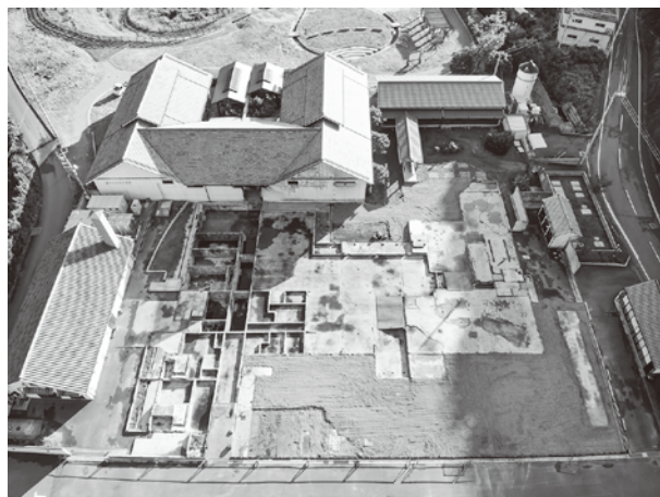
解体工事後の様子
