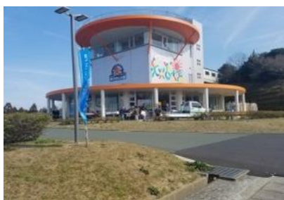
道の駅 伊方きらら館
