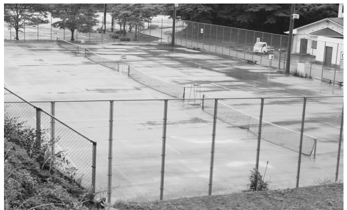
町民グラウンドのテニスコートを補修
